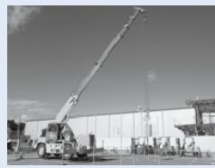
教習風景(ラフテレーンクレーン(つり上げ荷重10t))
