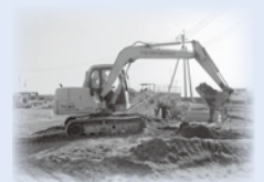
バックホー(0.25m³)による掘削作業
