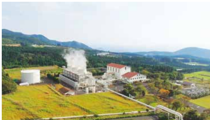
大霧発電所（霧島市牧園町）
