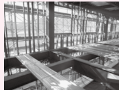
建築中の鹿児島教習所。 作業主任者の指揮の下で 安全作業が行われた。
