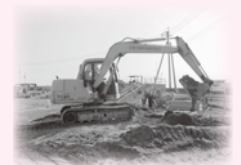
バックホー(0.25m³)による掘削作業
