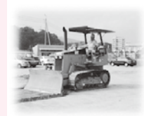
ブルドーザーによる押土作業
