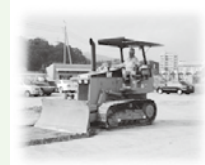
ブルドーザーによる押土作業
