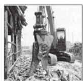
鉄骨切断機 （鉄骨を切断）
