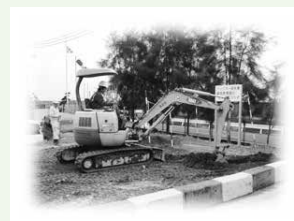
小型バックホーの掘削作業
