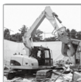
解体用つかみ機 （木造工作物を解体）
