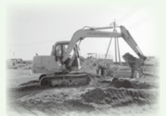
バックホー（0.25m³）による掘削作業
