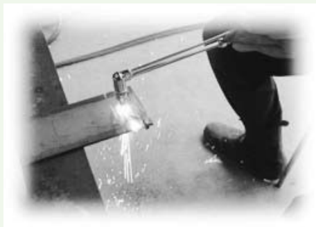
鉄板等の溶断作業には、ガス溶接装置が広くもちいられている。
