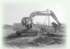
バックホー(0.25m³)による掘削作業
