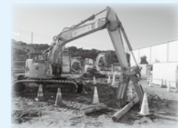
ブレーカ（左写真）及び、新たに追加された解体用建設機械のアタッチメント（下）
