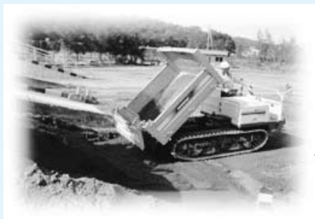
ダンプ作業中の不整地運搬車 (最大積載量2.5t)
