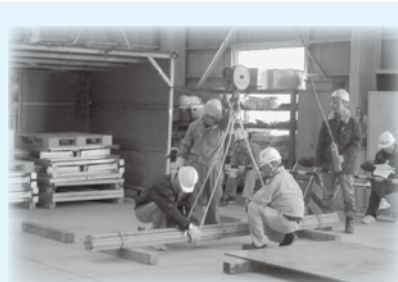
つり荷のバランスを取り水平に上げることが必要とされる玉掛け作業
