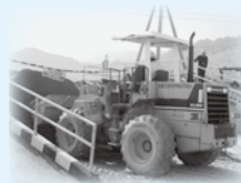
掘削作業中のトラクターショベル(タイヤ式)
