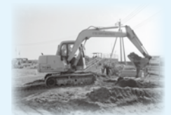
バックホー(0.25m 3 )による掘削作業
