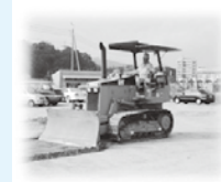
ブルドーザーによる押土作業
