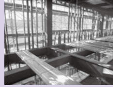
建築中の鹿児島教習所。 作業主任者の指揮の下で 安全作業が行われる。
